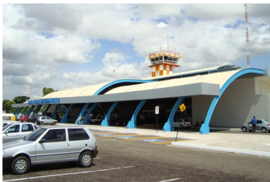
Reforma, ampliação e urbanização do TPS do Aeroporto de Boa Vista
