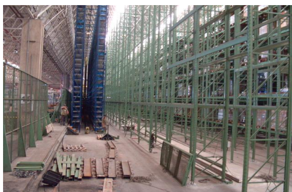
Transelevador no Terminal de Logística de Carga do Aeroporto de Guarulhos (SP)
