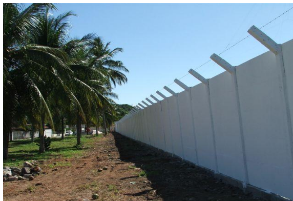
Obras do muro patrimonial do Aeroporto de Ilhéus (BA)
