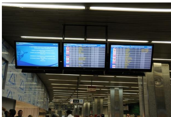
Execução da infraestrutura para implantação do sistema SIV do TPS1 do AIRJ
