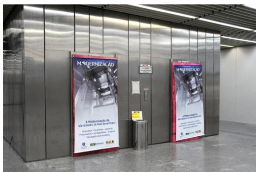
Substituição dos elevadores no AIRJ
